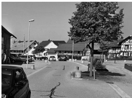
Situation vor den Bauarbeiten im Jahr 2022
