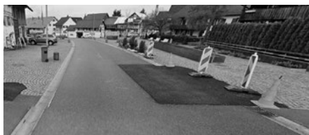
Situation während den Bauarbeiten im Zeitraum 2023 bis 2025
