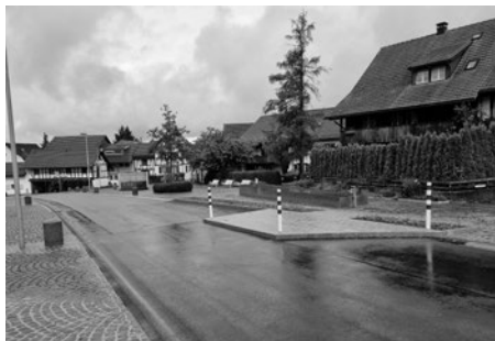
Situation nach den Bauarbeiten bzw. der Instandstellung Ende Juli 2025
