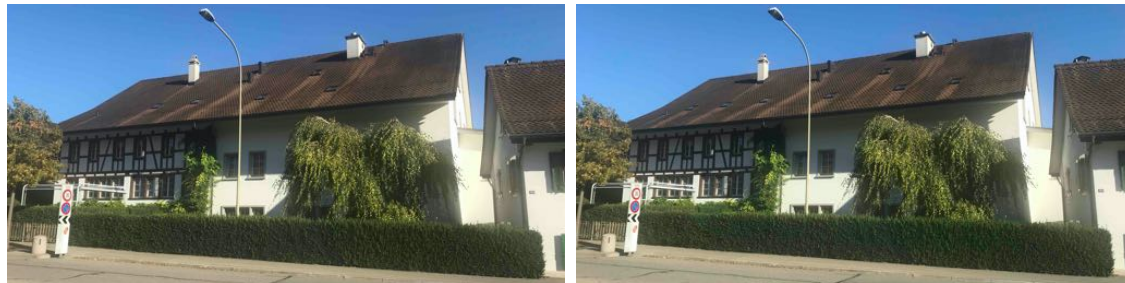
Vers.-Nr. 115, schutzwürdige Baute gemäss Detailplan, mit 7 statt 5 Dachflächenfenster (Dachfläche ca. 330 m 2 )
