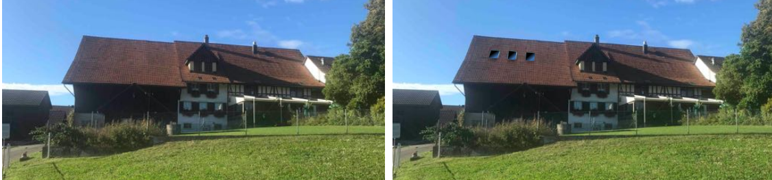
Vers.-Nr. 119, schutzwürdige Baute gemäss Detailplan, mit drei neuen Dachflächenfenster (Dachfläche ca. 130 m 2 )
